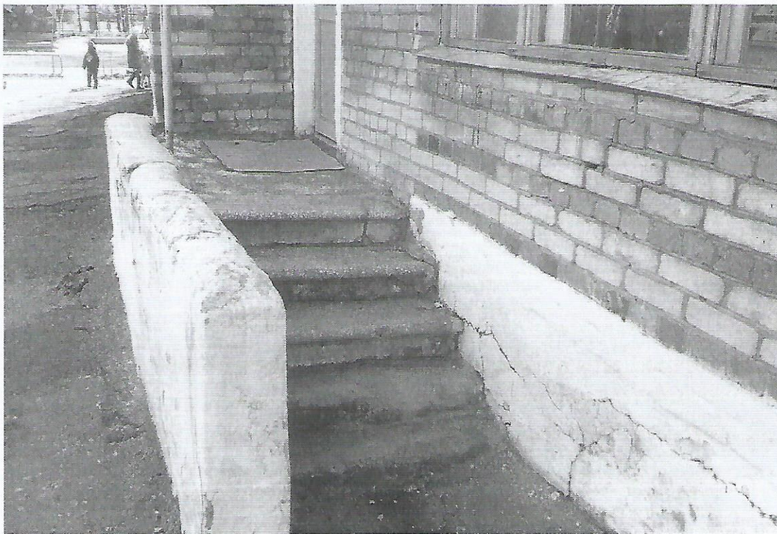
Фото № 9. Пути эвакуации
