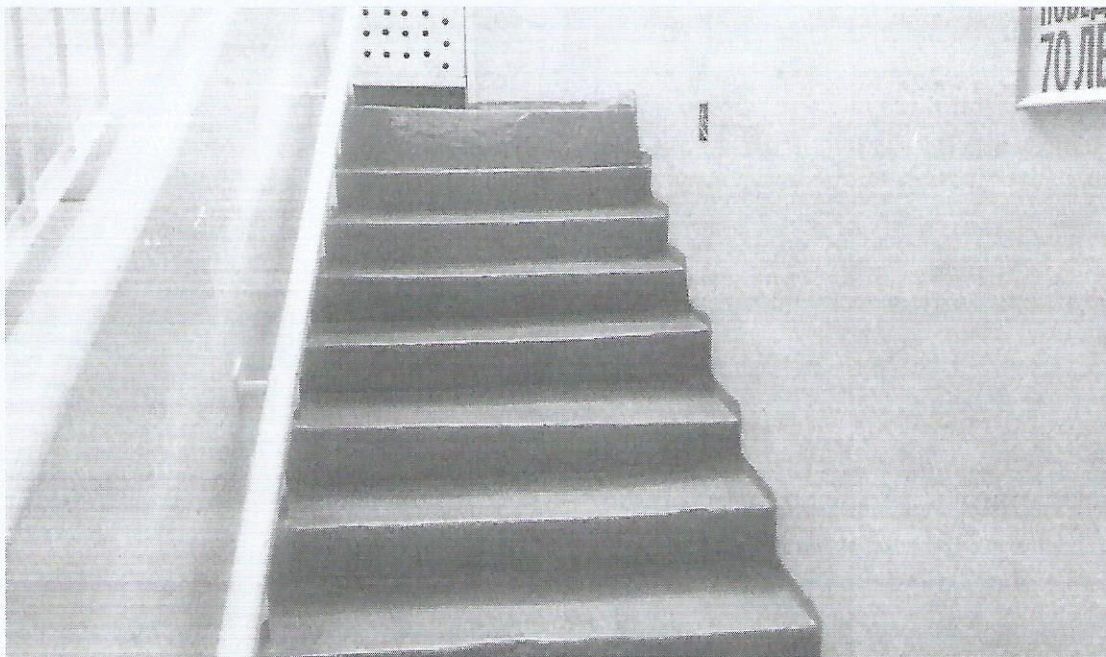
Фото № 7. Лестница (внутри здания)
