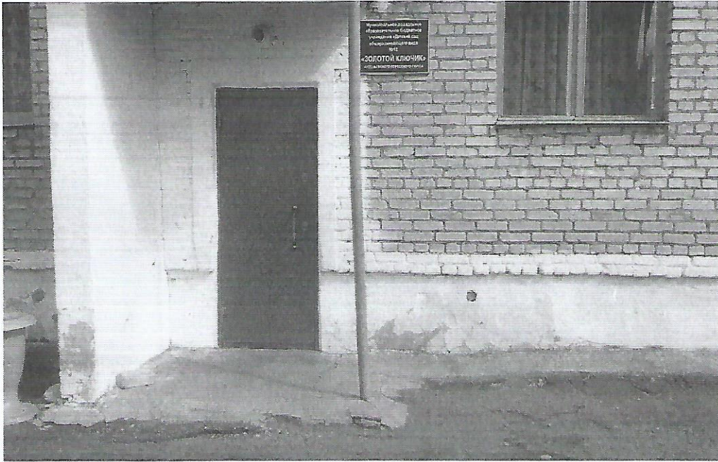
Фото № 3. Входная площадка (перед дверью)
